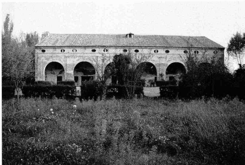
Gli edifici architettonicamente connotati
