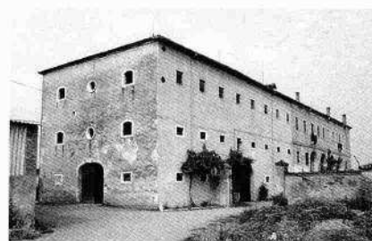
Il complesso edificato visto da sud (R.M. 1989)
