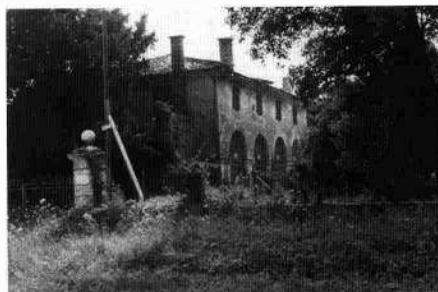
Scorcio della facciata occidentale (Archivio IRVV) Veduta della barchessa porticata (Archivio IRVV)
