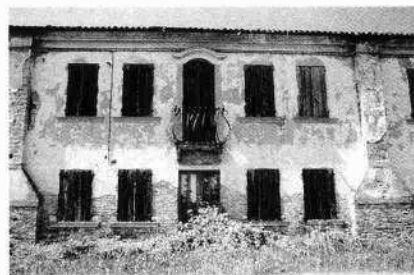
Il complesso edificato visto da sud-ovest (N.P. 1999)
