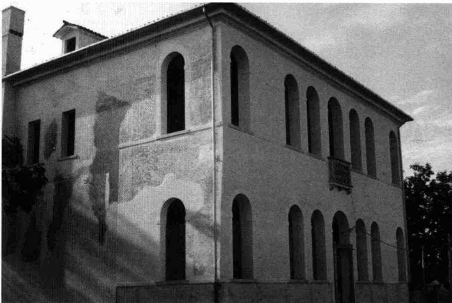
Il fronte est con l'abbaino timpanato in costruzione (L.S. 1998)
