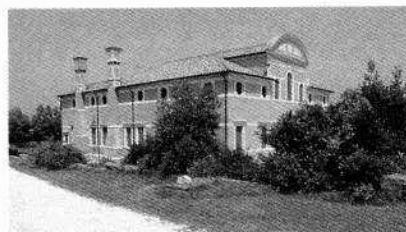
Il fronte meridionale dell'edificio residenziale (R.M. 1988)
