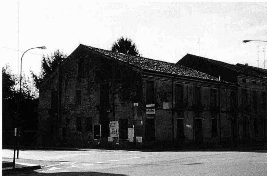
Il fronte principale della casa padronale (M.G.P. 1999)
