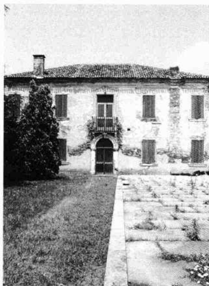
Il complesso edificato visto da sud-est (M.B. 1989)
