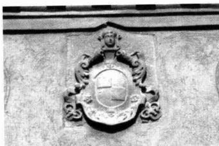
La torre colombara La barchessa orientale Particolare della trifora di facciata Lo stemma sul fronte meridionale
