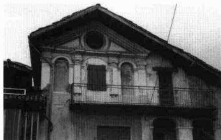
Veduta dell'edificio prima della ristrutturazione (Archivio IRVV, 1989) L'edificio sul lato nord-occidentale della corte oggi (A. Dalla Caneva, 2003)
