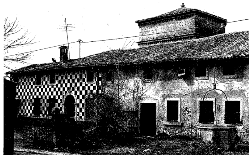
Fig. 5: L'edificio posto lungo il lato nord della corte, appoggiato a una delle due torri-colombare; la parte in primo piano era, in origine, un porticato aperto con pilastri quadri in bugnato.
