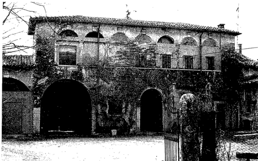
Fig. 4: L'edificio che chiude la corte a sud-ovest; il loggiato, ora chiuso, si apriva in origine sulle due facciate secondo una tipologia poco usata in Valpolicella.
