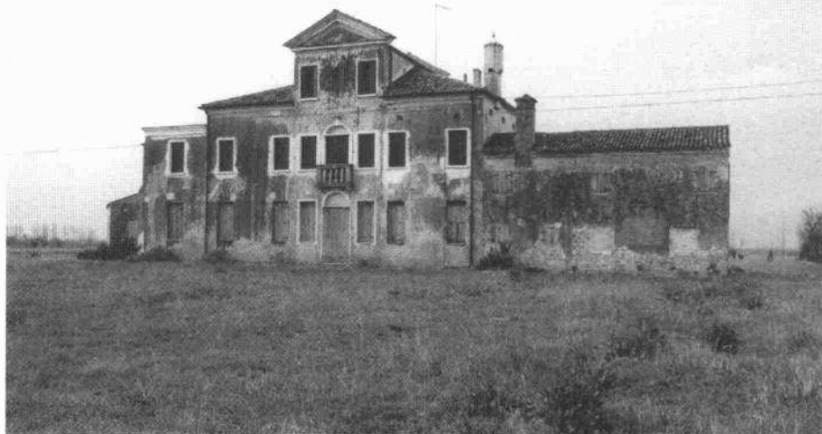
Veduta del fronte rivolto al fiume (Archivio IRVV)
