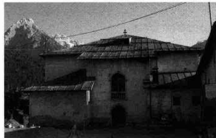
Vista del fronte posteriore (C. Benvegnù, 2003) Scorcio del prospetto laterale (C. Benvegnù, 2003)
