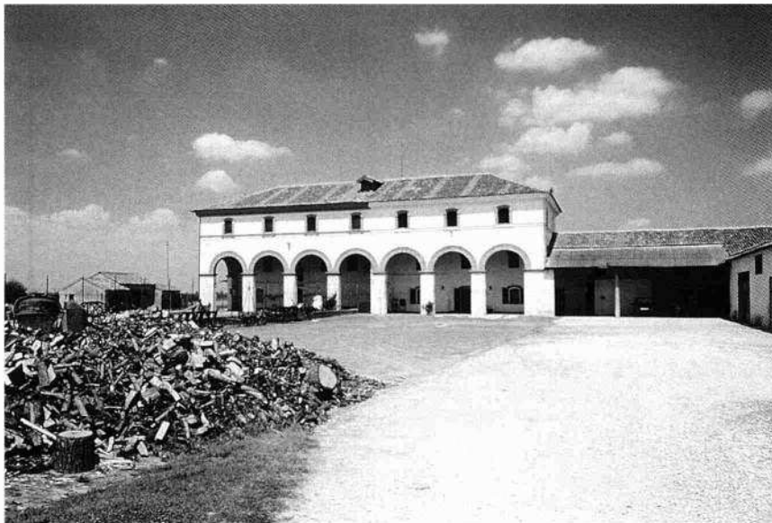
Il fronte principale dell'edificio residenziale (G.T. 1999)
