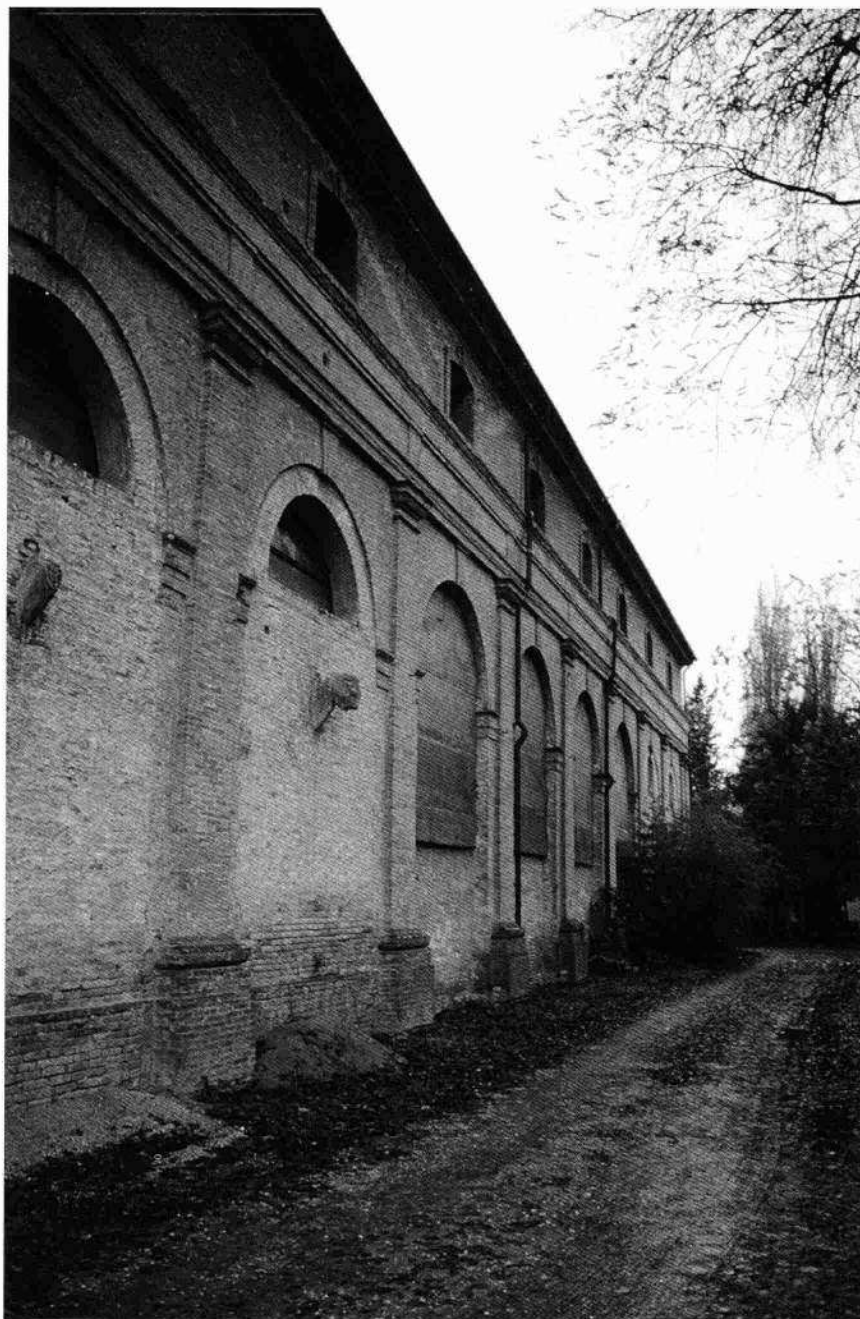
Scorcio del fronte meridionale delle scuderie (G.T. 1999)
