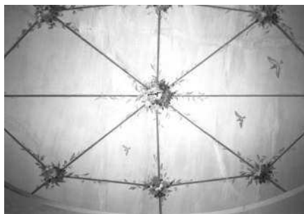
Particolare del soffitto a volta della scala (Archivio IRVV)
