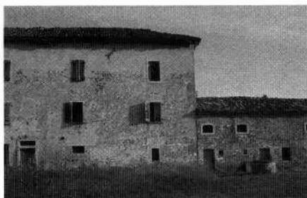
Facciata posteriore verso la corte (C. Benvegnù, 2003) Particolare del fronte principale (C. Benvegnù, 2003)
