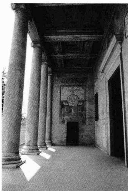
Il fronte interno del prolungamento dell'ala settentrionale (R.M. 1989)
