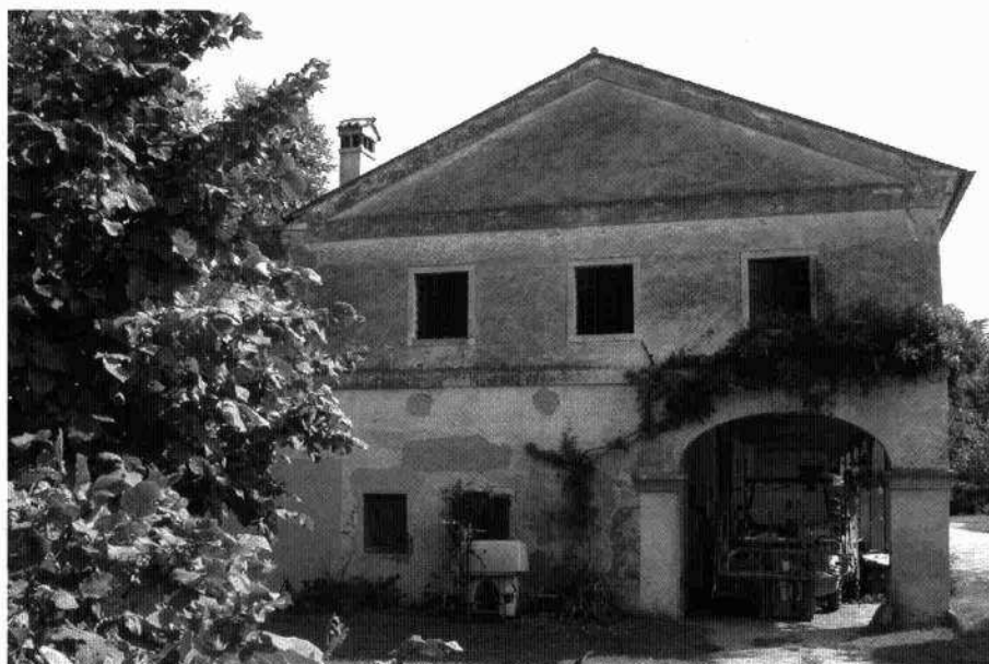
La facciata meridionale della barchessa occidentale Il fianco occidentale della barchessa
