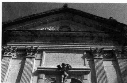
Particolare della facciata dell'oratorio (L. De Bortoli, 2003)
