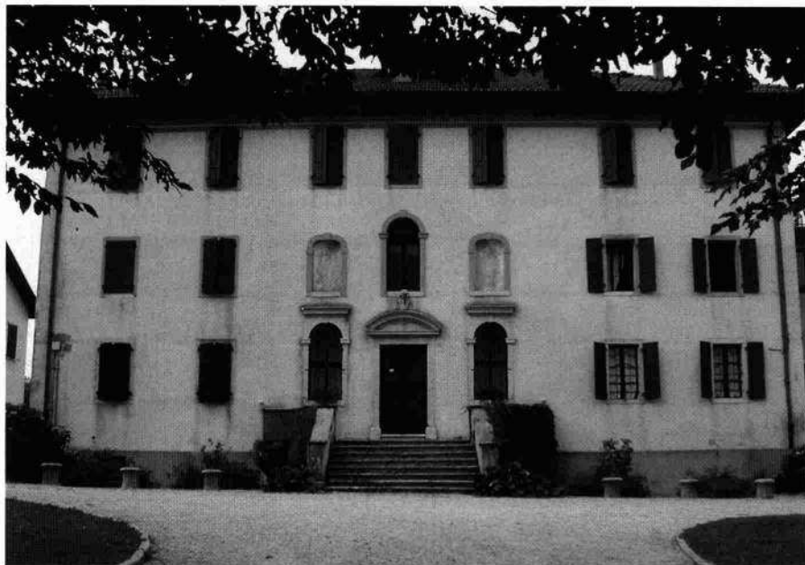
Veduta del complesso (Archivio IRVV, 1989)
