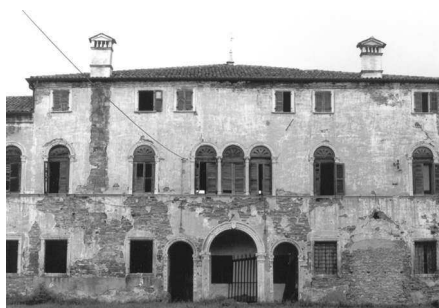
L'affaccio principale visto dal giardino, rivolto verso la piazza (Archivio IRVV) Il nucleo di Isola Rizza, già chiamata Isola Porcarizza, in una mappa del Settecento in cui appare villa Buri (Archivio IRVV)
