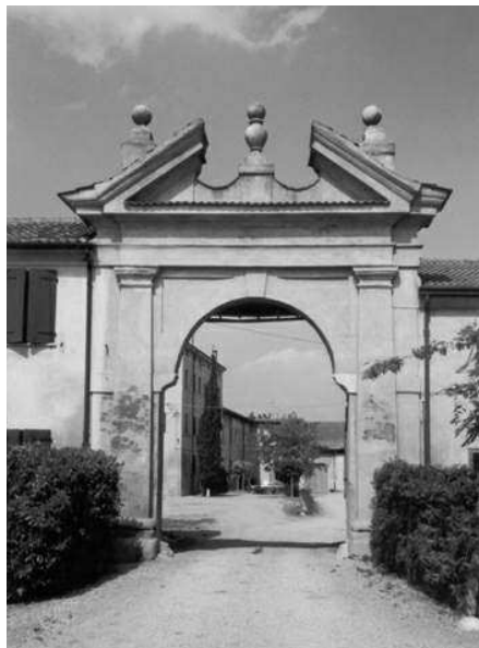
Il portale barocco di accesso alla corte (Archivio IRVV)
