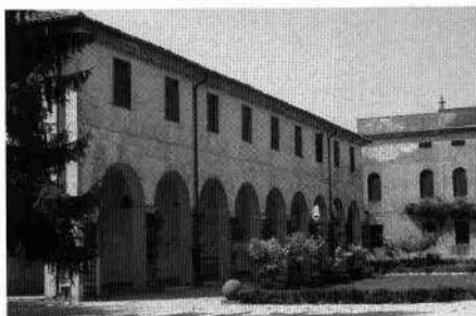
La parte centrale della facciata Il giardino antistante Gli annessi settentrionali e meridionali dall'esterno
