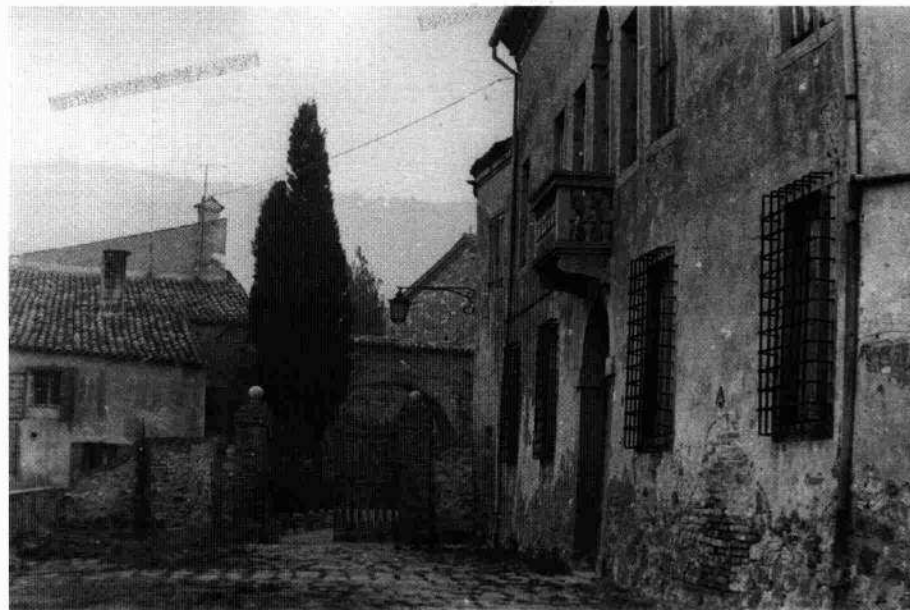
Il fronte e la corte prima dei lavori di restauro
