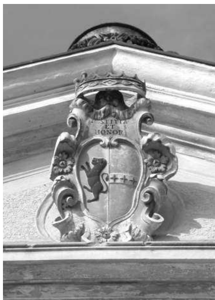
Stemma gentilizio sul timpano di facciata (N.L.) Statua acroteriale di facciata (N.L.)
