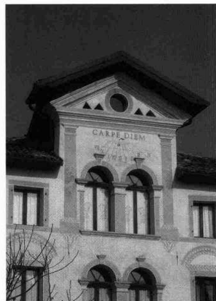
Veduta del retro della villa (L. De Bortoli, 2003) Particolare del fronte principale (L. De Bortoli, 2003)
