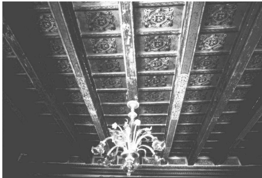
Soffitto ligneo dipinto della fine del XVI secolo (Archivio IRVV)
