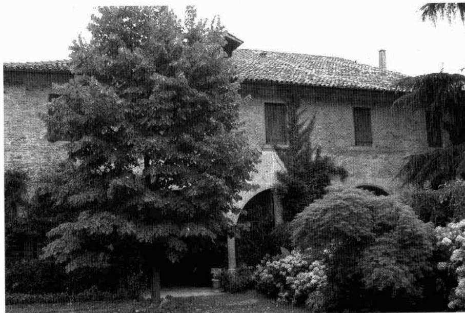
La torre colombara Il fronte occidentale della villa
