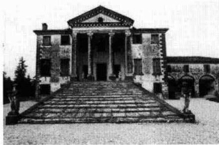
Il fronte occidentale Particolare della barchessa orientale Veduta del fronte principale
