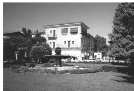
Veduta del fronte del complesso nelle sue forme attuali (Archivio IRVV)
