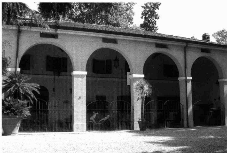
Veduta dal cancello d'ingresso del complesso Particolare della barchessa
