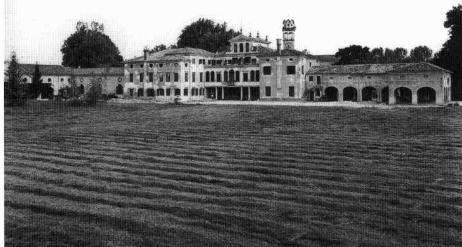
Veduta del fronte nord del complesso prospiciente il parco (Archivio IRVV)
