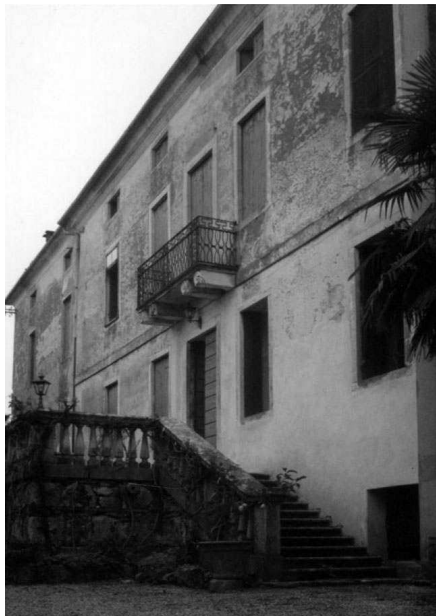
Prospetto sulla corte del settore meridionale
