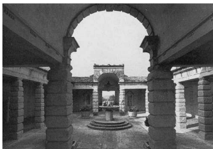
Il peristilio con fontana centrale (Archivio IRVV) Fronte nord del complesso (Archivio IRVV)
