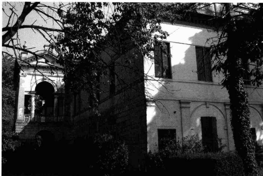
Il fronte della barchessa L'antico fronte principale a nord visto da occidente
