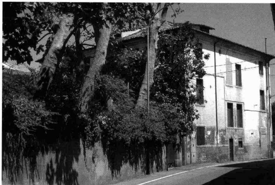
Parte del fronte settentrionale della villa e il fianco orientale con parte del parco
