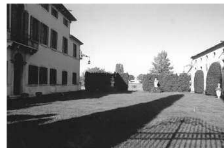
Il fronte principale della cappella (Archivio IRVV)
