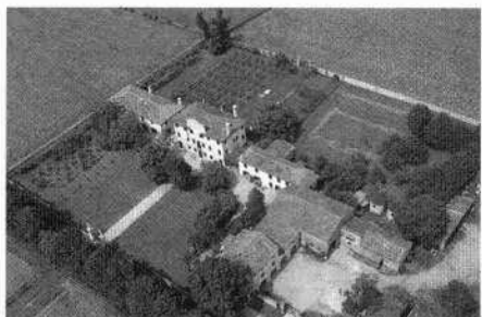
Scorcio della facciata principale (Archivio IRVV) Veduta aerea del complesso (da: Tonetto-Bellieni, 1995)
