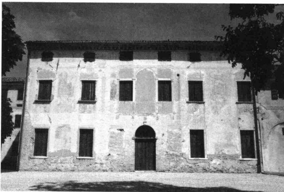
La lunga adiacenza sul lato occidentale della villa (L.S. 1998)
