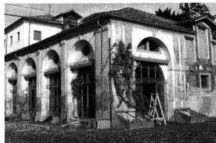
Particolare del portale e della portafinestra del fronte settentrionale Il fronte settentrionale Il fronte occidentale della villa La barchessa vista da est
