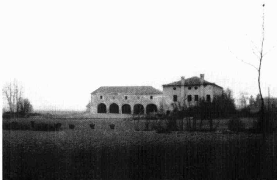
Particolare della barchessa negli anni settanta Il complesso negli anni settanta
