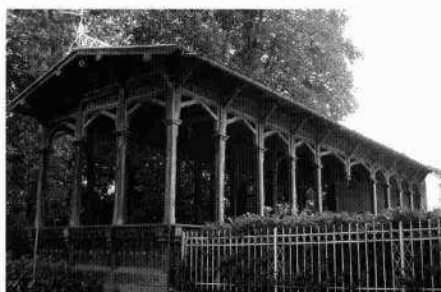
La barchessa Il prospetto meridionale Il prospetto occidentale della villa La loggia aperta
