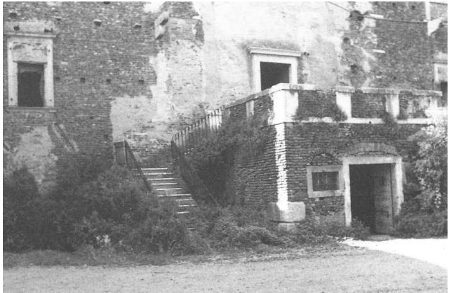
Particolare della scala d'ingresso alla villa (Archivio privato Scola Gagliardi)
