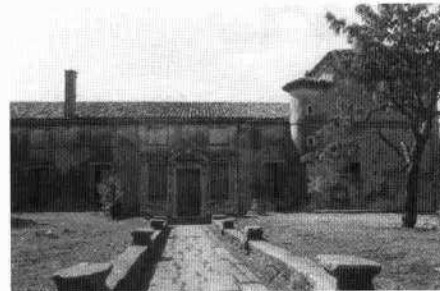
La villa in un disegno del XVIII secolo La loggia occidentale prima dell'intervento di restauro Il portale d'ingresso e il cortile posteriore
