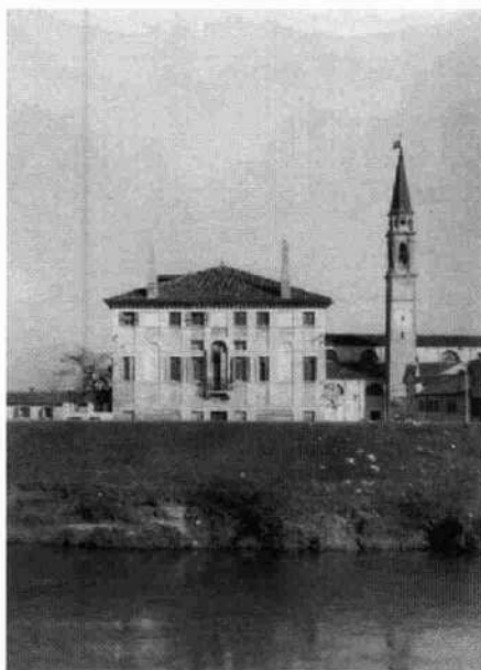
Il salone centrale Vista della villa da sud Veduta del fronte principale dall'argine del canale di Bovolenta
