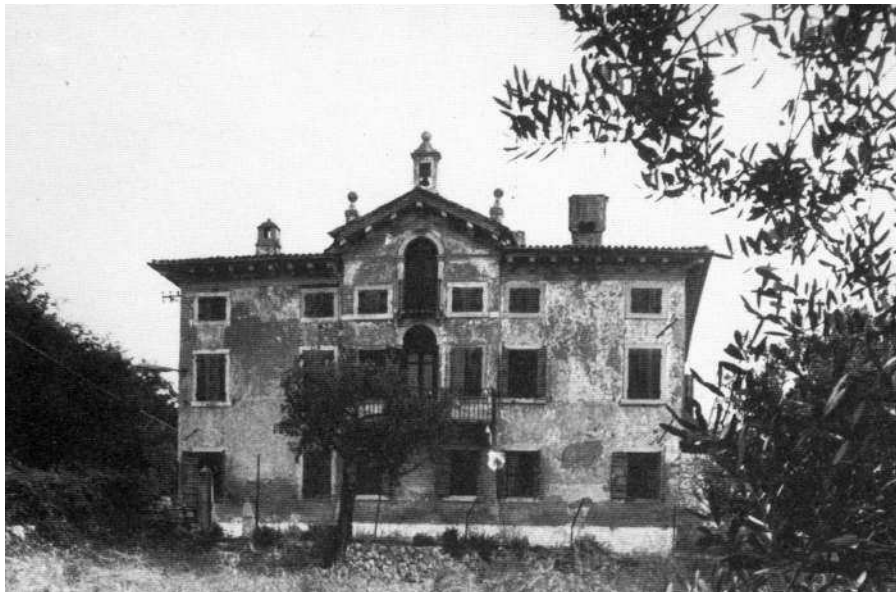
Vista della facciata principale della villa in una foto d'epoca (Archivio IRVV)
