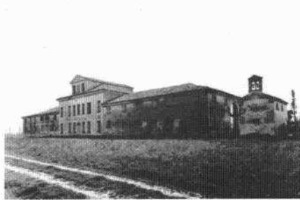
Scorci del complesso da sud-ovest e da nord-ovest prima del restauro (Archivio IRVV) La facciata sud prospiciente la campagna prima del restauro (Archivio IRVV)
