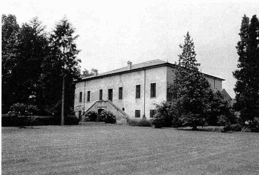
Gli edifici architettonicamente connotati
