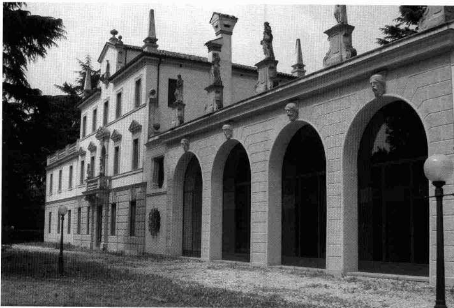
La facciata settentrionale Il corpo padronale e gli annessi visti da oriente
