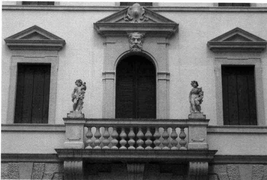
Scorcio del fronte meridionale visto da occidente Particolare della loggetta di facciata
